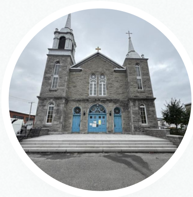
Réfection parvis, pilastres et escaliers extérieurs de l'entreprise Alex Maçonnerie inc.
