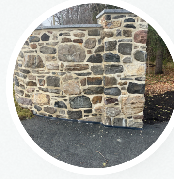
MUR GOUIN - Restauration du mur patrimonial de l'entreprise Atwill-Morin Maçonnerie
