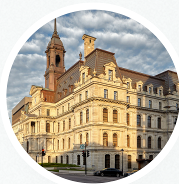
VDM _HDV_Lot 0401_maçonnerie de l'entreprise St-Denis Thompson
