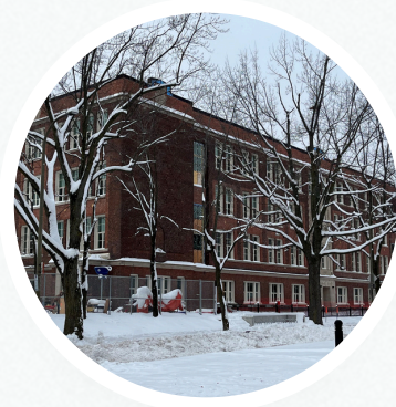
Réhabilitation majeure de l'école Maisonneuve de l'entreprise Les Constructions TREMCO inc.
