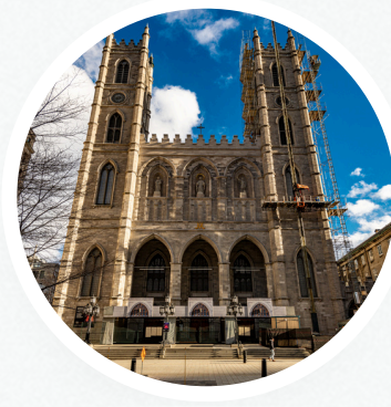
Basilique Notre-Dame - Restauration de la tour Ouest de l'entreprise Maçonnerie Rainville & Frères inc.
